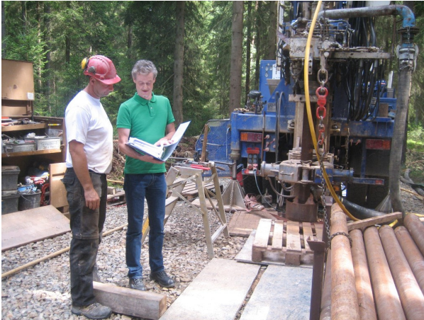
Bild von der Probebohrung
